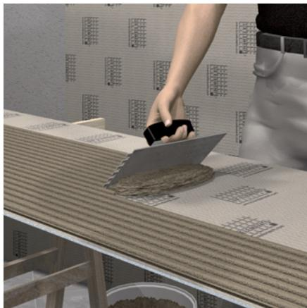
**Kleberbatzen** – Je nach Ebenheit des Untergrundes den Ansetzkleber COL-AK punktweise mittels Kleberbatzen (8 – 10 Stk. pro qm) auf einer Seite auftragen.
